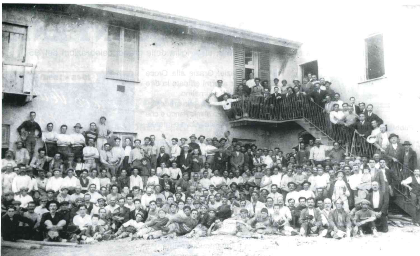
Foto d'epoca, con tanta nostalgia, dagli archivi della Cooperativa Stovigliai. Il terrazzino in cima alla scala sembra quasi crollare sotto il peso dei tanti lavoratori. Un'autentica folla
